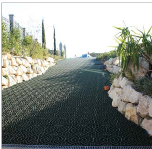
Rampa di accesso - posa
