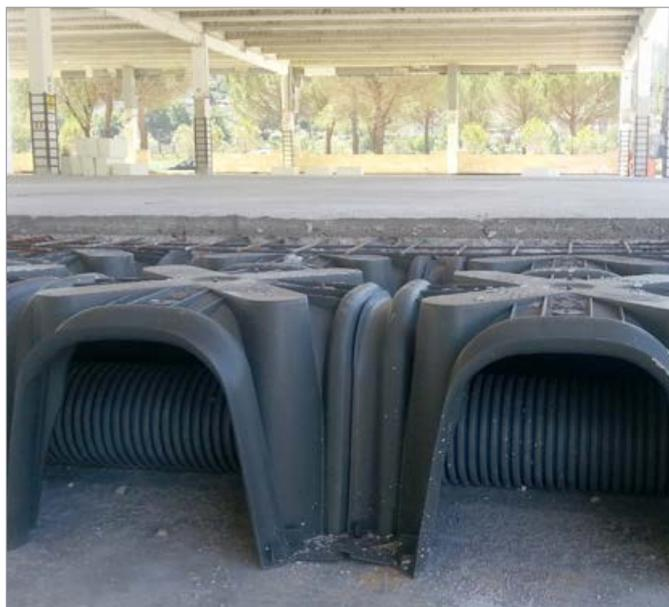
Passaggio degli impianti sotto pavimento in ogni direzione
