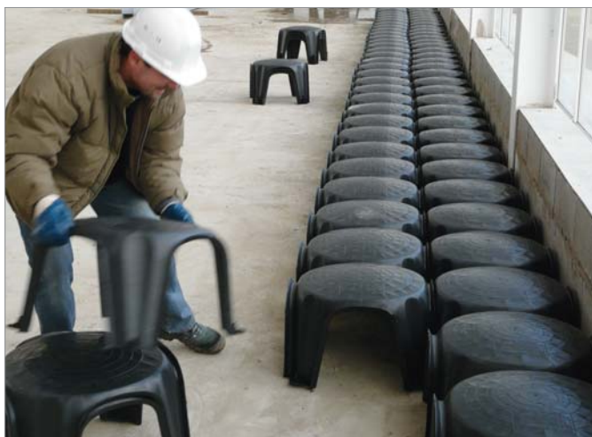
Rys. 3 - Szczegółowy widok połączeń typu "męski-żeński" - należy zwrócić uwagę na doskonale uszczelnienie stopy.
