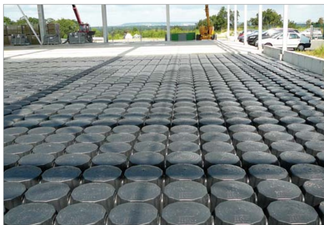
Intercapedine ventilata per edificio ad uso industriale
