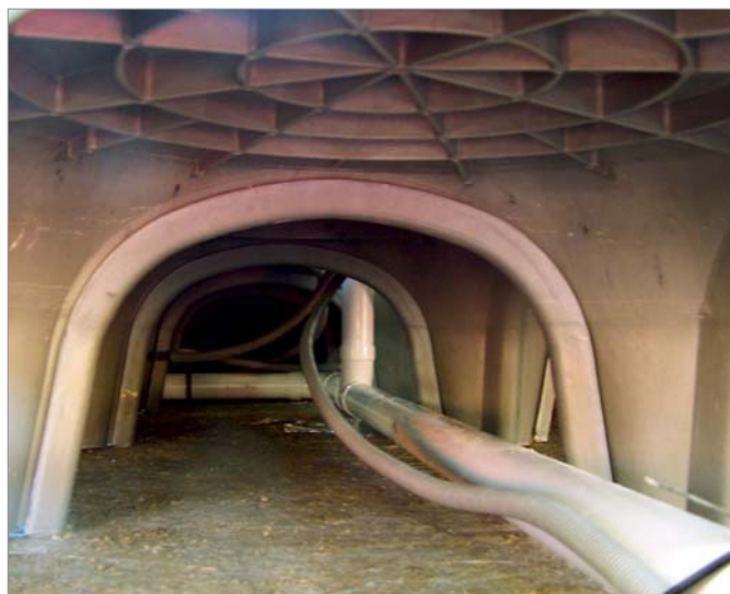
Przykład poprowadzenia przewodów użytkowych
