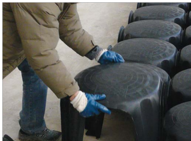
Rys. 3 - Szczegółowy widok połączeń typu "męski-żeński" - należy zwrócić uwagę na doskonale uszczelnienie stopy.
