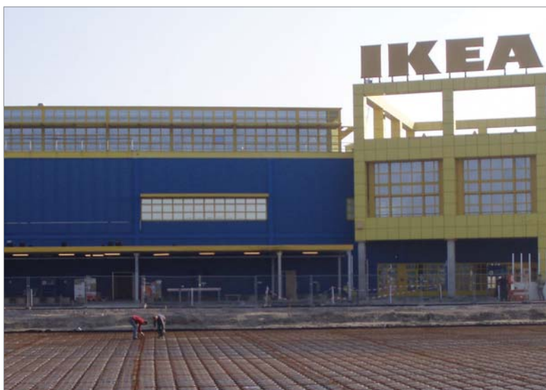
Zbiornik dyspersyjny znajdujący się pod parkingiem komercyjnym
