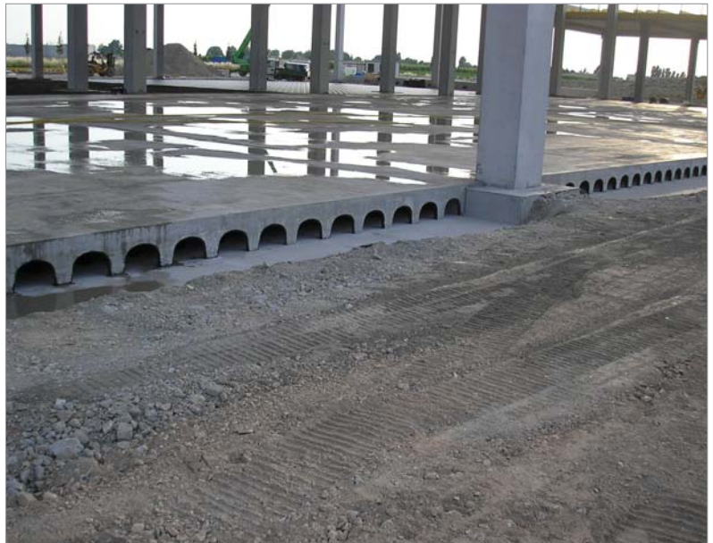
Wentylowana szczelina podpodłogowa do chłodni
