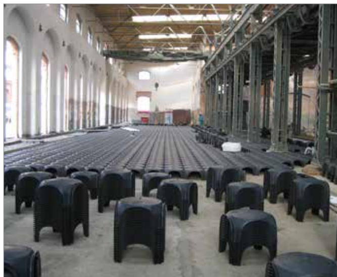
Rénovation de bâtiment commerciale
