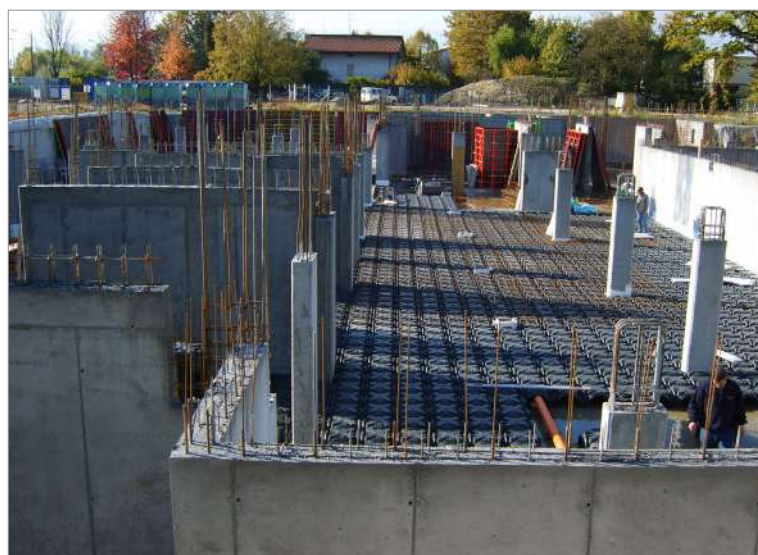
Vide ventilé - Logement à usage résidentiel
