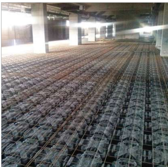
Double paroi aérée pour les bâtiments à usage industriel
