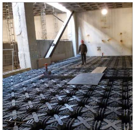
Rénovation bâtiment scolaire
