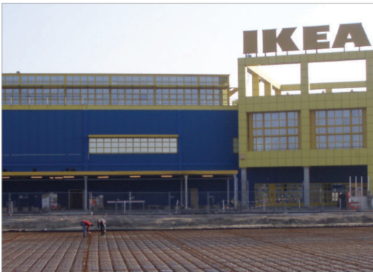
Bassin de dispersion d'eau ci-dessous d'un parking commerciale
