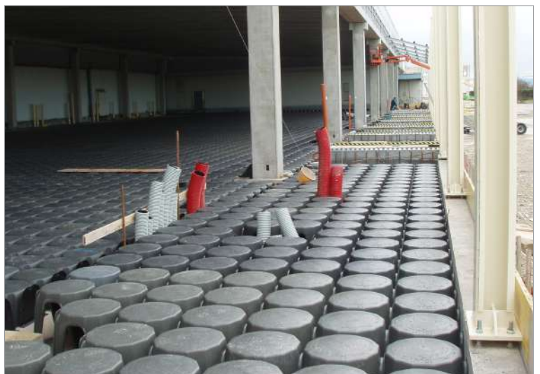
Double paroi aérée pour les bâtiments à usage industriel
