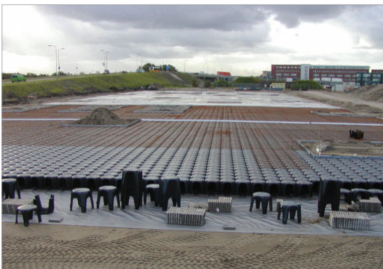
Vide sanitaire pour bâtiment à usage industriel
