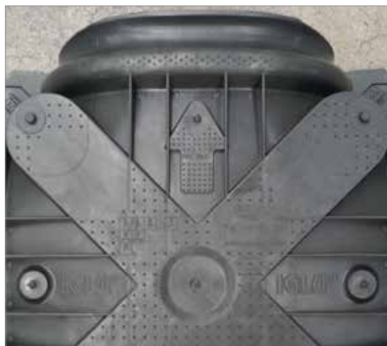
Fig. 1 - Pose à sec du premier coffrage, la flèche est tournée vers la cornise.
