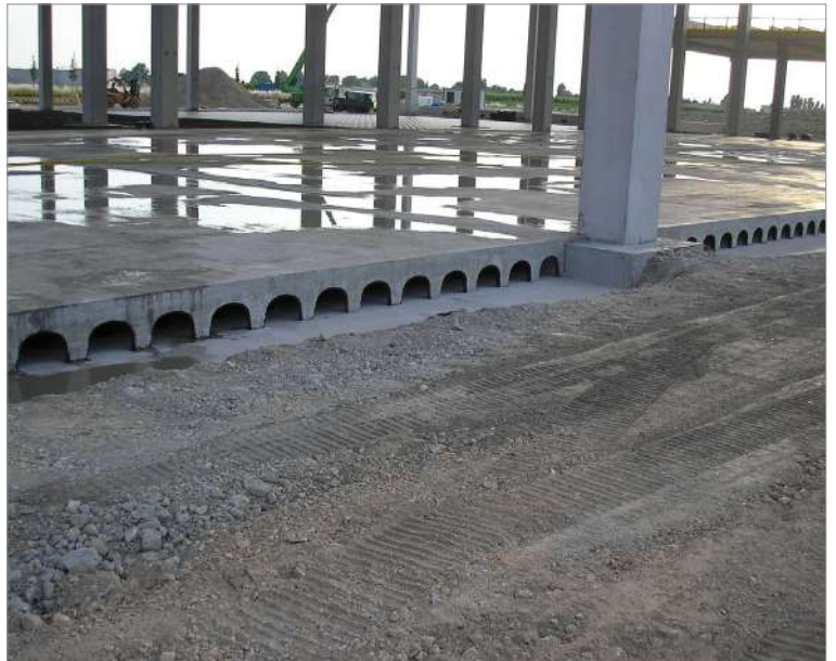
Vide sanitaire ventilée pour chambre froids
