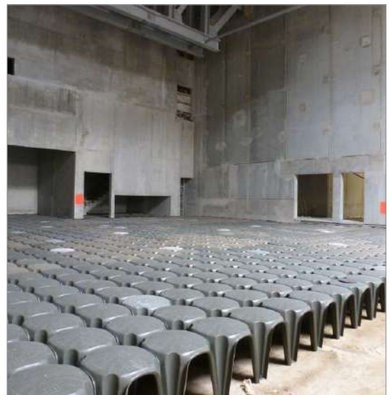
Rénovation bâtiment scolaire
