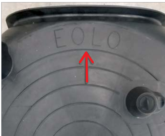
Fig. 1 - Torr placering av den första formsättningen, är pilen riktad mot trottoarkantens grund.
