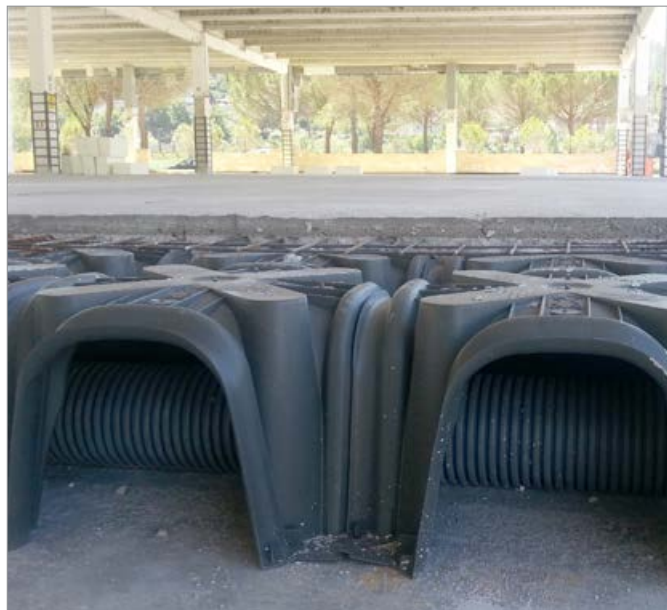
Ejemplo de paso de instalaciones
