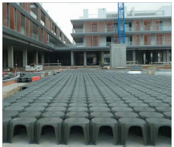
Construcción de una plaza para un conjunto residencial
