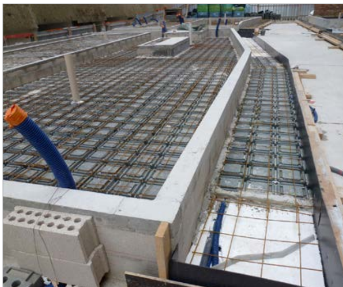
Fácil construcción de rampas de acceso
