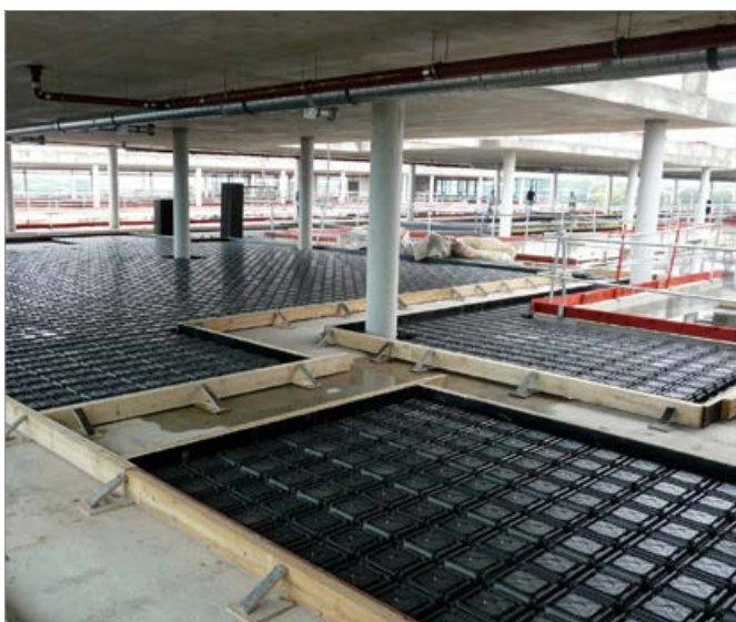
Elevación de soleras intermedias para edificio de oficinas
