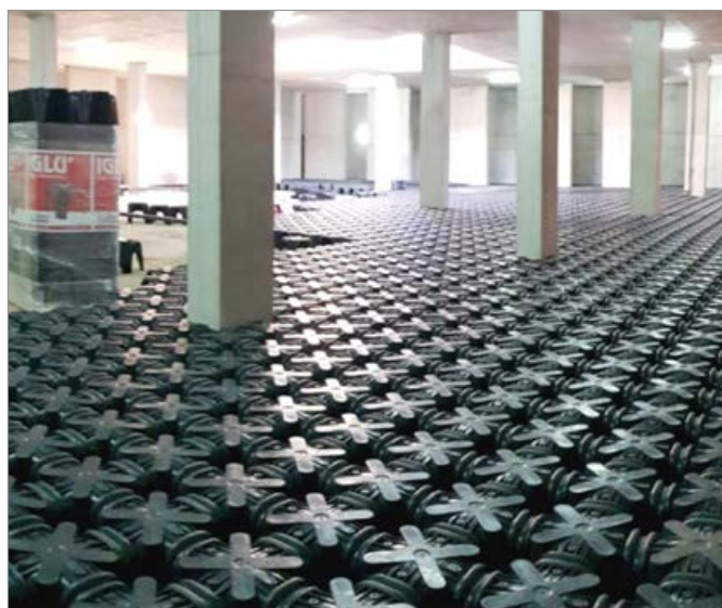
Rehabilitación de un edificio hospitalario
