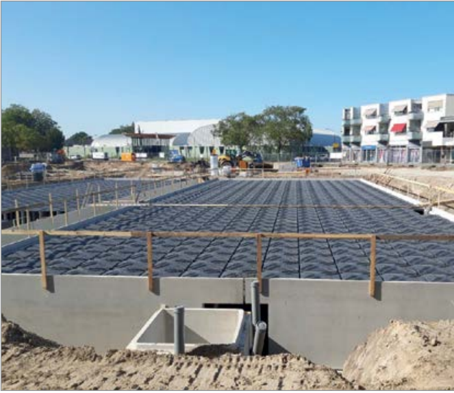
Park alanının altındaki dağıtım deposu
