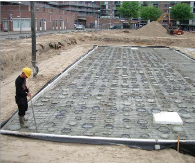
Park alanının altındaki dağıtım deposu
