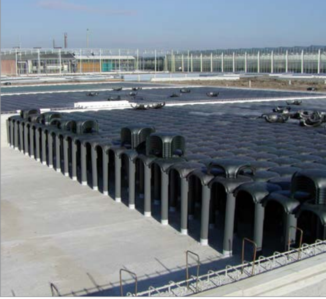
Seradaki su toplama depoları
