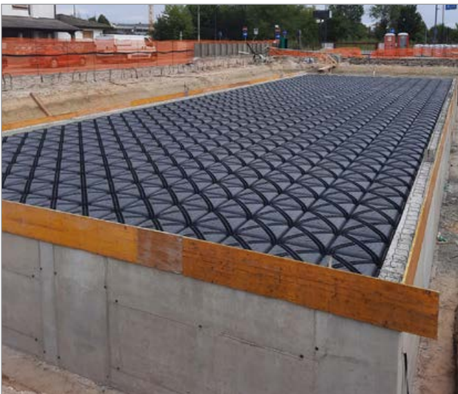
Endüstriyel bölgenin altındaki su toplama tankı
