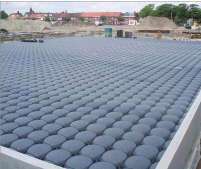
Endüstriyel bölgenin altındaki su toplama tankı
