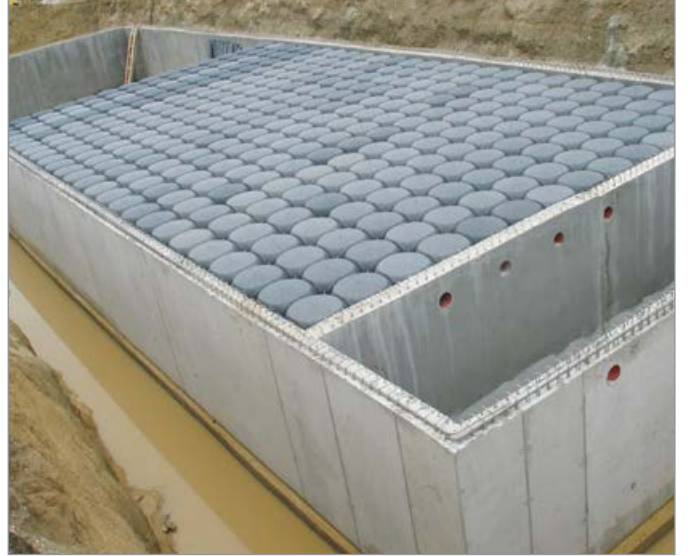
Endüstriyel bölgenin altındaki su toplama tankı
