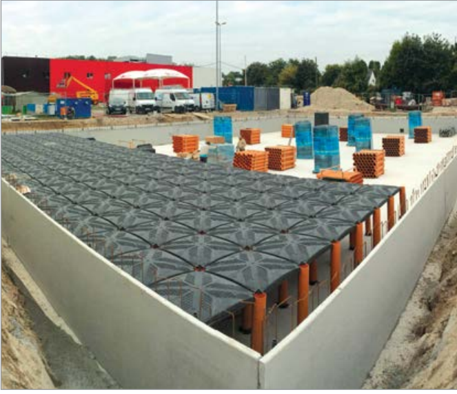
Endüstriyel bölgenin altındaki su toplama tankı
