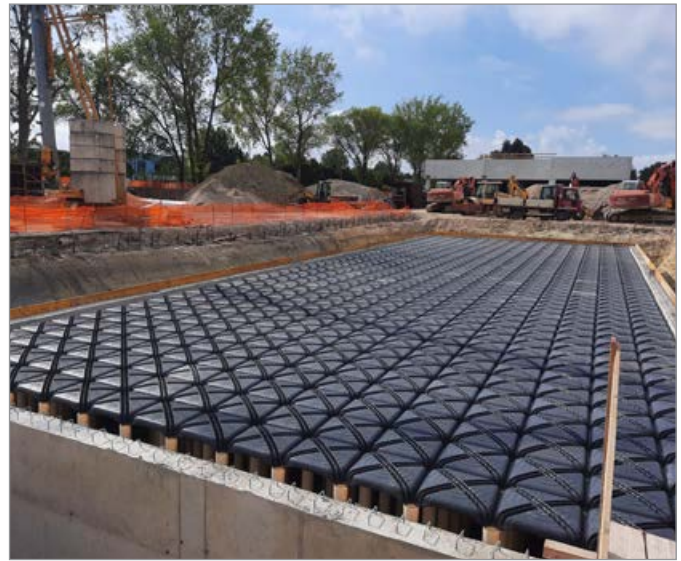
Endüstriyel bölgenin altındaki su toplama tankı
