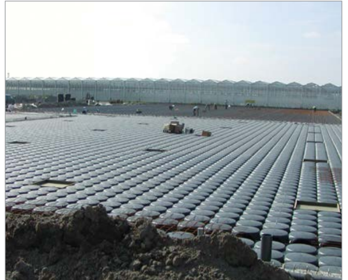
Seradaki su toplama deposu
