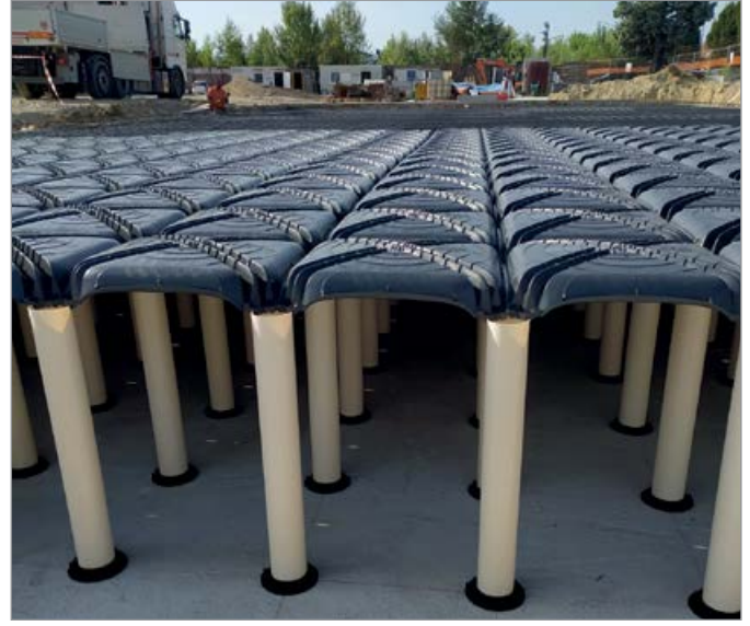
Endüstriyel bölgenin altındaki su toplama tankı
