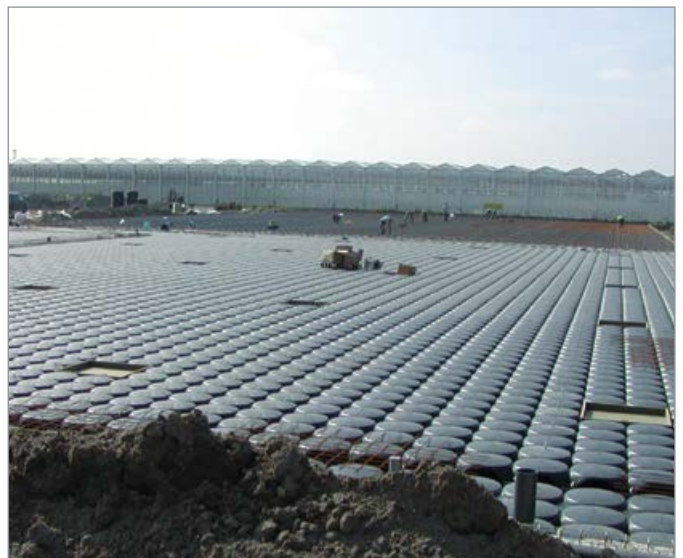
Wassersammelbecken in einem Treibhaus
