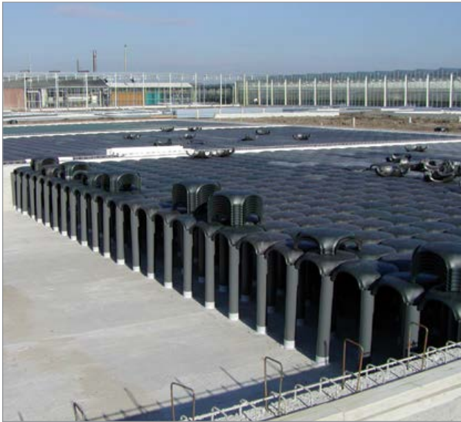
Wassersammelbecken in einem Treibhaus
