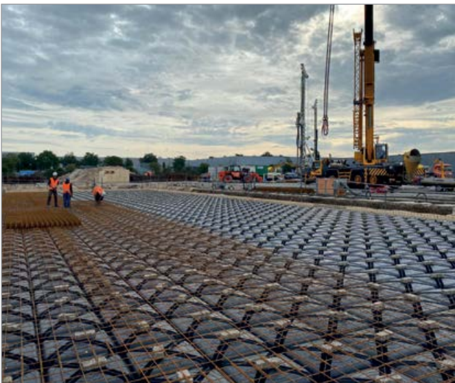
Wassersammelbecken unter einem Industriebereich
