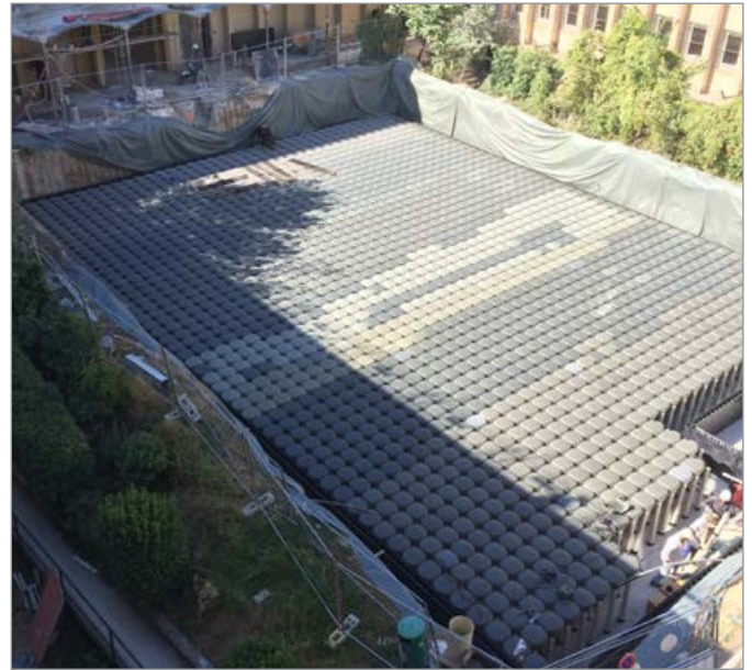
Wassersammelbecken unter einem Wohnbereich
