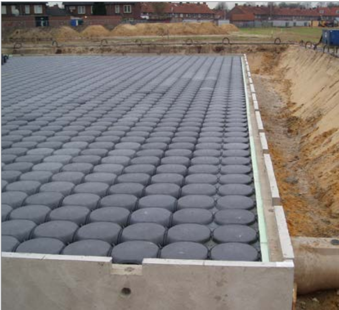
Sammelbecken unter einem begrünten Bereich
