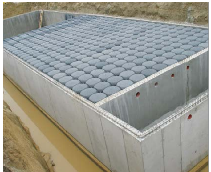
Wassersammelbecken unter einem Industriebereich
