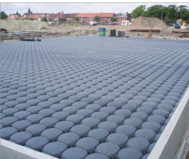
Sammelbecken unter einem Industriebereich
