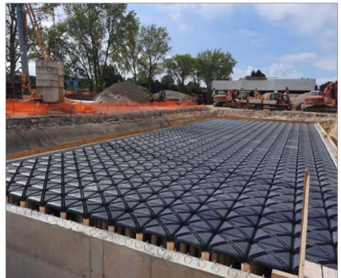
Wassersammelbecken unter einem Industriebereich
