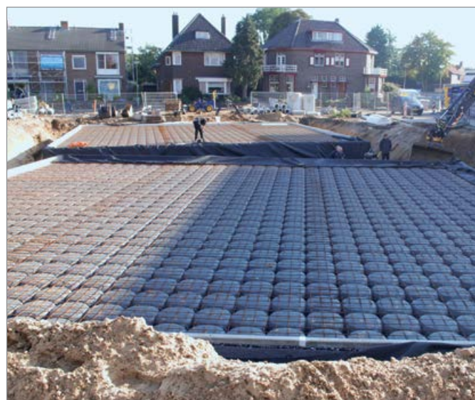
Spridningstank under torg
