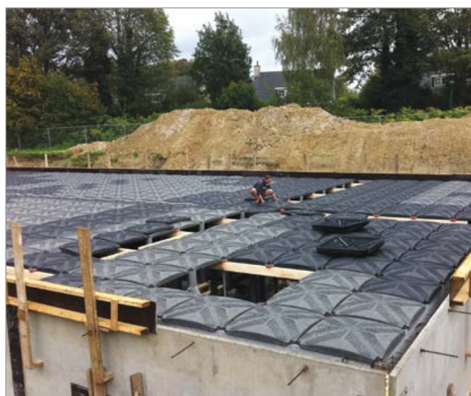
Regnvattensamlings tank
