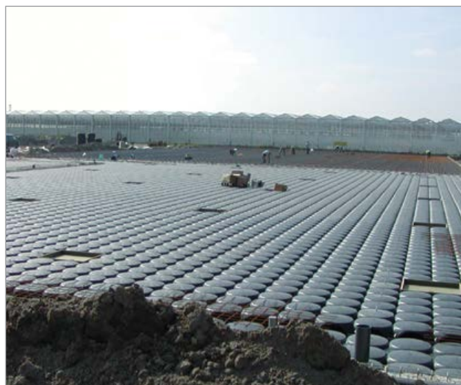
Vattensamlings tank i växthus
