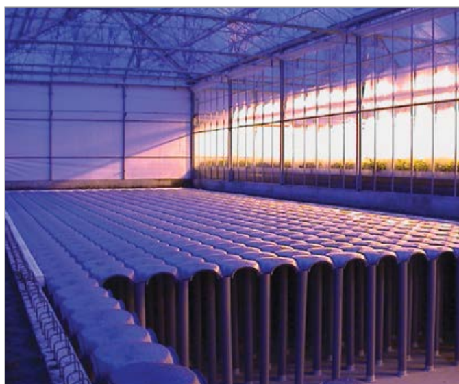
Vattensamlings tank i växthus
