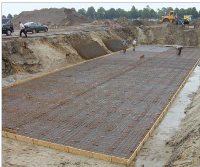
Vattensamlings tank
