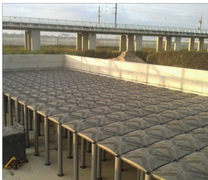
Vattensamlings tank
