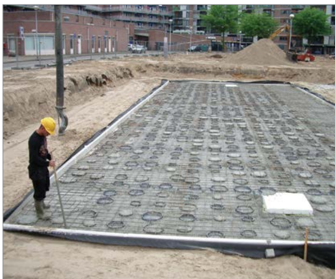
Zbiornik dyspersyjny pod parkingiem
