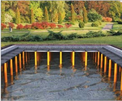
Con respecto a las cisternas de recogida, las cisternas de dispersión no son perfectamente impermeables sino que permiten que el agua pluvial filtre gradualmente a la capa, a través de ranuras en las paredes o de un fondo drenante.
