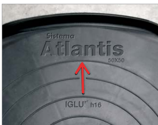
Рис. 1 - Установка всухую первого элемента опалубки, стрелка направлена к обвязке фундамента.
