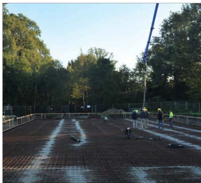
Сборочный бассейн воды
