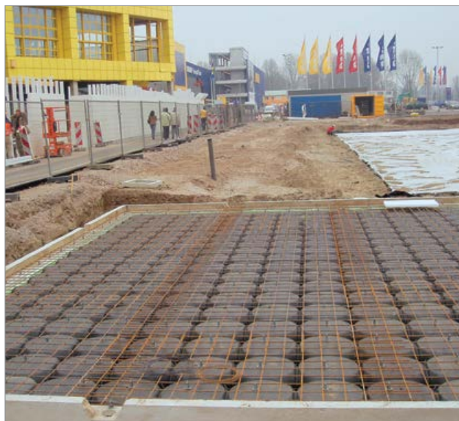
Резервуар для распределения воды под коммерческой стоянкой
