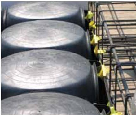
4 Nach der Montage der ersten Schalungen Atlantis, die Zwischenbügel auf dem Panel anbringen und Bügel und Bänder der sich gegenüber befindlichen Pfeiler mit Stahlgabeln (in der Baustelle bereithalten) verbinden.
