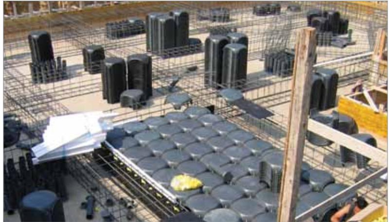
Gemäß dem Zweck, dem sie dient, **bzw. Schnelligkeit und Einfachheit in der Ausführung der Baustellenarbeiten**, zeichnet sich die Schalung durch **wenige einfache und leichte Teile** aus, die eine intuitive und schnelle Montage mit zahlreichen Vorteilen erlaubt:
