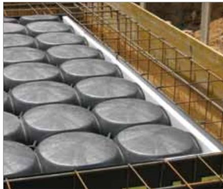
5 Je nach Höhe, die erreicht werden soll, weitere Panele aufsetzen, die immer mit Bügeln und Bändern befestigt werden. Die Montage der Schalungen Atlantis beenden und die offen gebliebene Seite der Schalungen entlang dem Perimeter mit Polystyrolleisten abdecken.
