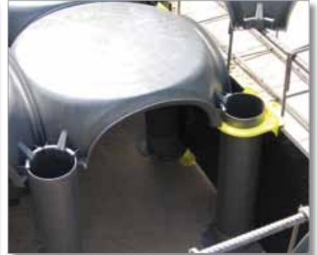
3 Das Startpanel in die entsprechende Führung an den unteren Bügeln einsetzen und oben mit den Bändern, die sich an den Pfeilern befinden, befestigen.
