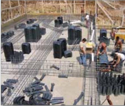
1 Vorbereitung der Eiseneinlagen des Fundaments auf dem zuvor ausgeführten Magerbetonboden.
