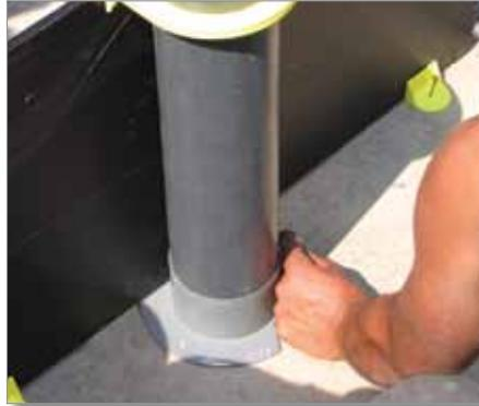
2 Am Boden entlang der internen und umlaufenden Fundamentträger, der unteren Bügel und der Rohrfüße mit einem gleichmäßigen Abstand von etwa 50 cm festnageln.
