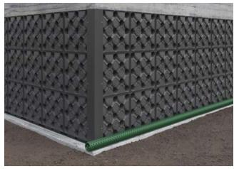
Das Drainagerohr entlang des Gebäudes und an der Wand verlegen.
