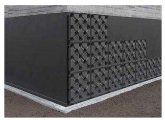
Nach Befestigung der Abdichtungsbahn mit der Verlegung der Iglu'® Barrier beginnen.
