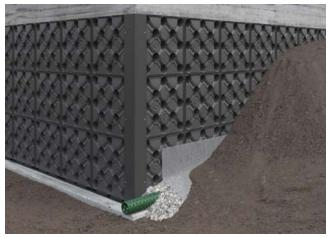
Das Drainagerohr mit Kies und dann mit Geotextil abdecken. Danach mit der Verfüllung fortfahren.
