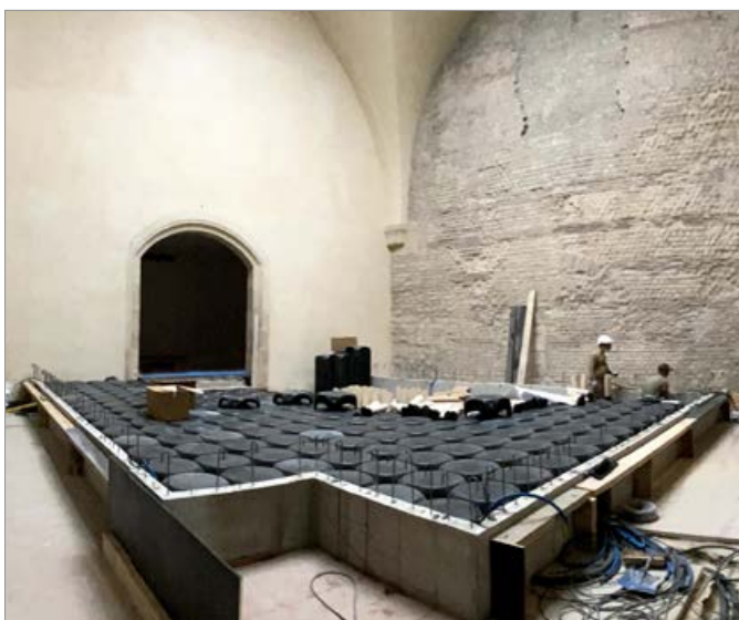
Höjda golv för passage av system
