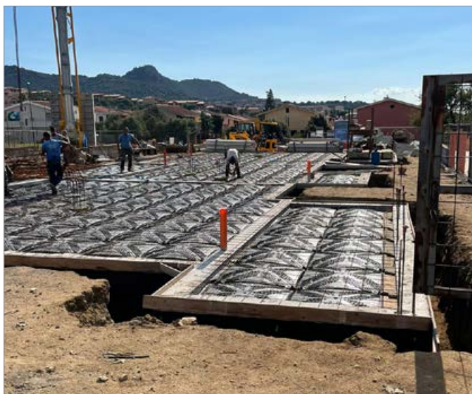
Ventilerat hålrum för bostadshus
