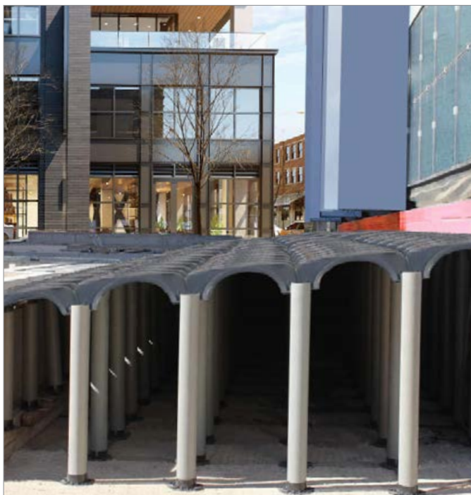
Enkel konstruktion av ramper
