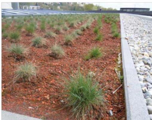
Jardim suspenso (ou telhado verde suspenso) extensivo é uma tipologia de cobertura verde para superfícies médias, grandes, com capacidade de carga reduzida, que não necessita de custos particulares de realização e manutenção devido ao substrato de espessura limitada e tipologia de vegetação pertencente a espécies muito resistentes e com raízes pouco profundas (gramíneas, sedum, erbáceas perenes).
