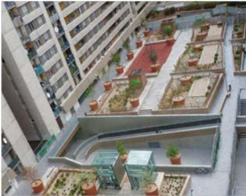
Jardim suspenso (ou telhado verde suspenso) intensivo é a solução mais representativa do jardim tradicional. Esta solução permite a escolha entre um número altíssimo de espécies diferentes, que incluem também arbustos e árvores de terceiro nível e necessita de um elevado nível de manutenção.
