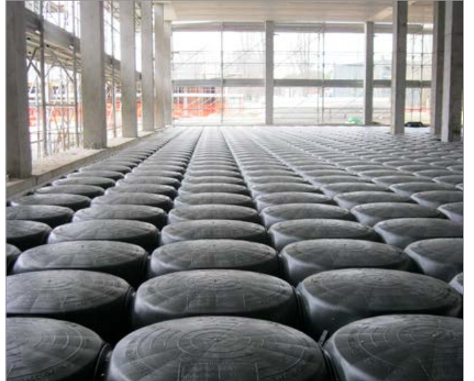
Sihhi kullanım için bir bina için havalandırılmış boşluk
