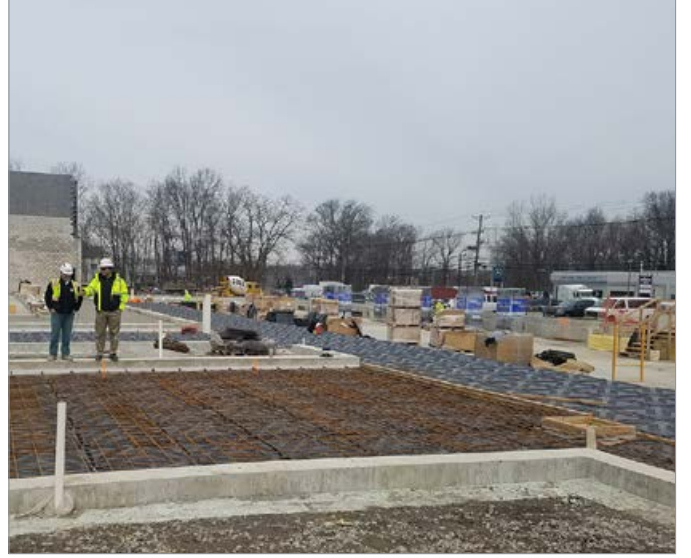
Endüstriyel kullanıma yönelik bir bina için havalandırılmalı zemin altı boşluğu
