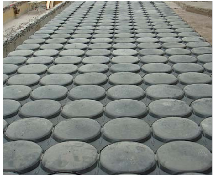
Atlantis sistemi ve Beton Up - çevre tarafından desteklenen yekpare levha
