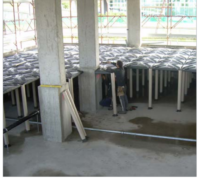
Endüstriyel kullanıma yönelik bir bina için havalandırılmalı zemin altı boşluğu
