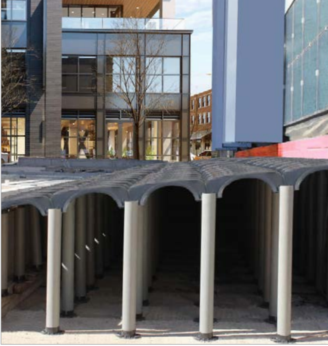
Eriřim rampalarının kolay yapımı
