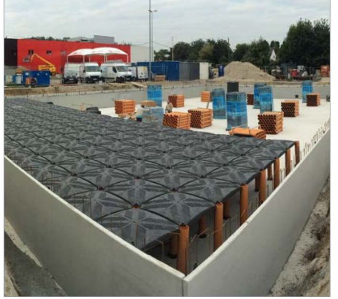
Bir alışveriş merkezinin altında yağmur suyu biriktirme tankı
