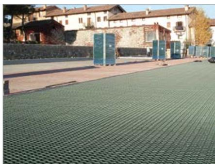
Das praktische Einhängen, das geringe Gewicht der einzelnen Gitter und die Modellierbarkeit in verschiedenen Formen (es genügt eine einfache Säge) ermöglichen eine schnelle und effiziente Verlegung von E.C.O. sowohl auf großen als auch auf kleinen Oberflächen. Nach Vorbereitung eines tragenden Untergrundes entsprechend den Bedingungen vor Ort und der Zweckbestimmung ist wie folgt vorzugehen:
