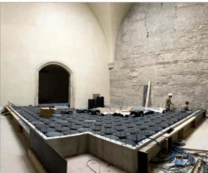
Anheben des Fußbodens für den Durchgang der Rohre
