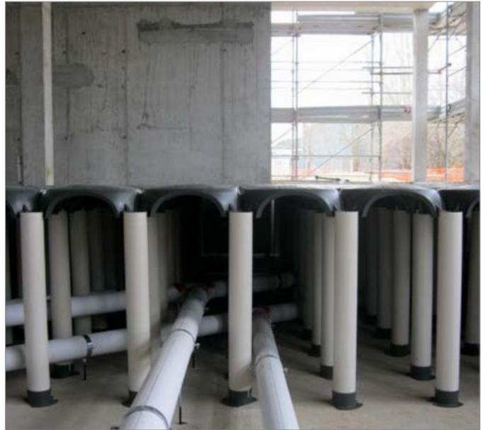
Durchführung der Analgen unter den Fußböden in alle Richtungen
