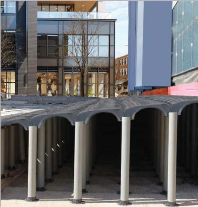
Einfache Konstruktion von Zugangsrampen
