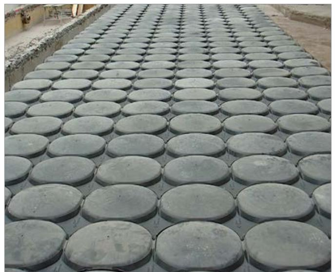
Atlantis-System und Beton up - monolithische Decke unterstützt vom Umfang
