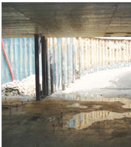
Applikationsexempel: Underjordisk parkerings byggnad med den "top-down"-teknik.
