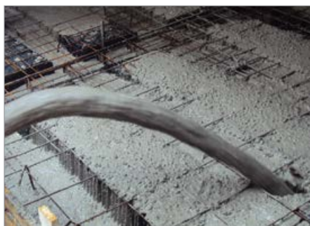
Ilustracje przedstawiające w kolejności układanie modułów, zbrojenie i wykonanie wylewki betonowej.
