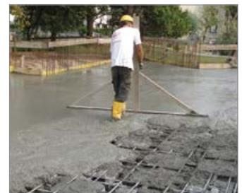
Einzelansichten der kompletten Reihenfolge der Gerüstaufstellung, Errichtung des U-Boot® Betons, vor Ort auszuführende Verstärkung der Struktur, Schüttung und anschließende Glättung.
