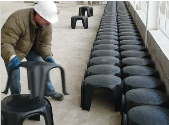
Şekil 3 - Erkek-dişi sistemi birleştirme fazının detaylı görünümü – ayakların mükemmel contasını unutmayın.
