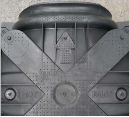
şek. 1 - İlk kalıbın kuru yerleştirilmesi, ok yönü kenar taşıını gösterir şekilde olmalı
