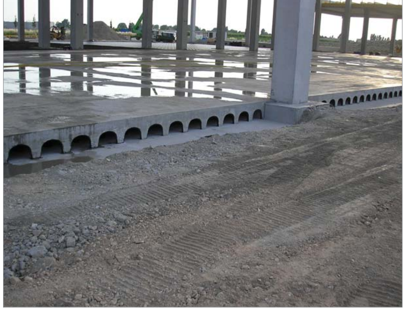
Soğuk oda için havalandırmalı zemin altı boşluğu
