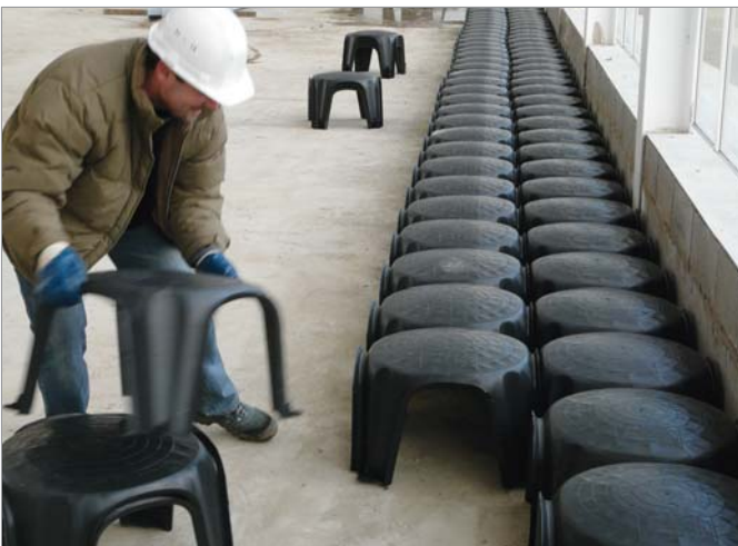
Fig. 3 - Détail de la phase d'enclenchement du système mâle-femelle - Remarquer le parfait scellage du pied.
