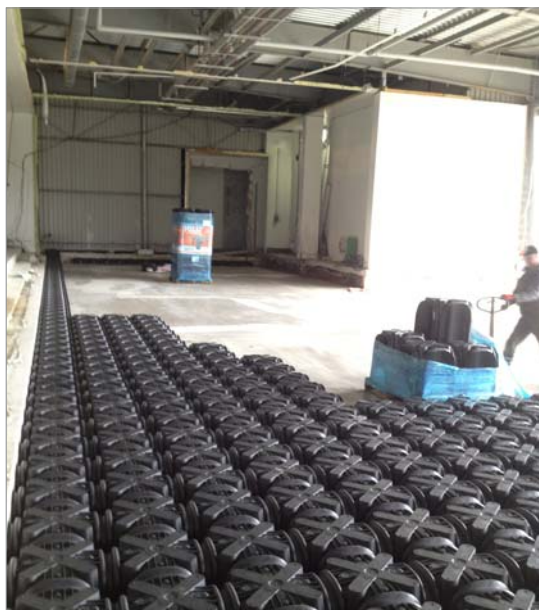
Chambre froide négative - Chatillon En Vandellais (France)
