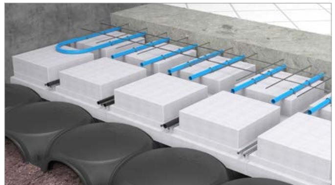
**4** Pose des armatures de la dalle de finition et des armatures à l'intérieur des nervures. Ensuite, procéder à la coulée de béton de la dalle nervurée qui devra être bien « battue » (surtout sur les côtés et dans les coins), battu sur toute son épaisseur, nivelé et taloché (à la main ou avec hélicoptère) selon la règle de l'art. Avoir avoir attendu le séchage du béton, il est possible de procéder à la pose du sol, selon le projet.
