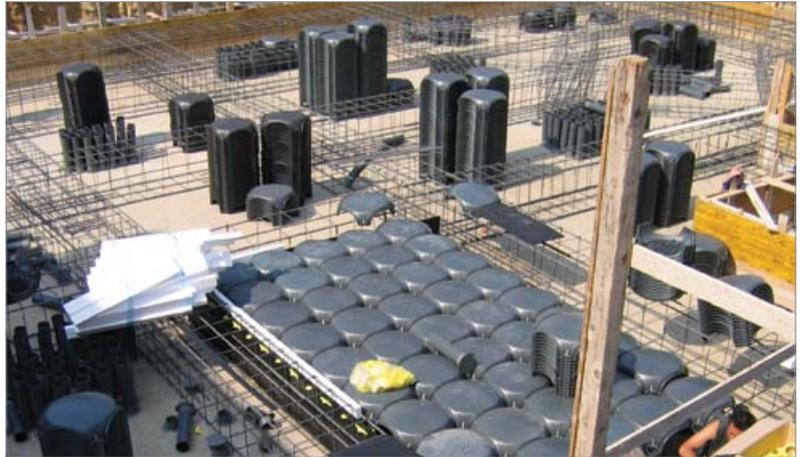
Le coffrage Mur, dans le but qu'il recherche, c'est-à-dire rapidité et facilité d'exécution du travail de chantier, est caractérisé par quelques parties simples et légères qui permettent un montage intuitif et rapide avec des nombreux avantages :
