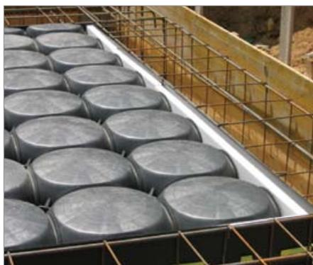
**5** Superpose, toujours en le bloquant à l'aide des accroches et des colliers, d'autres panneaux en fonction de la hauteur nécessaire à atteindre. Compléter le montage des Atlantis et boucher avec les lattes en polystyrène le côté resté ouvert des coffrages le long du périmètre.
