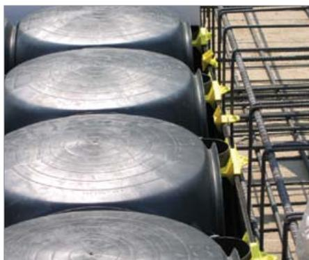
**4** Après avoir monté les premiers coffrages Atlantis, placer les accroches intermédiaires sur le panneau et continuer à relier entre eux les accroches et les colliers de tuyaux opposés à l'aide des épingles en acier (à préparer sur le chantier).
