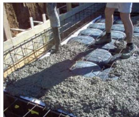
**6** Commencer la phase de coulage du béton armé en commençant par les tuyaux pour continuer avec les corniches et la dalle.
