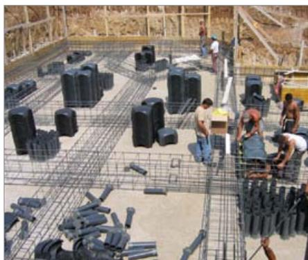
**1** Préparer les armatures de fondation sur fond en béton maigre réalisé précédemment.
