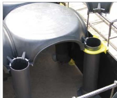
**3** Disposer le panneau de départ en l'insérant dans la glissière prévue à cet effet des accroches inférieures en le bloquant supérieurement à l'aide des colliers enfilés sur les tuyaux.
