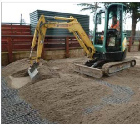
**1 RÉALISATION D'UNE COUCHE PERMÉABLE** (pierraille à grain variable 3-10 mm) d'environ 15-20 cm. Éventuelle couche de base de sable siliceux nivelée de manière opportune d'environ 4 cm. Pose du géotissu avant de développer le pavage.
