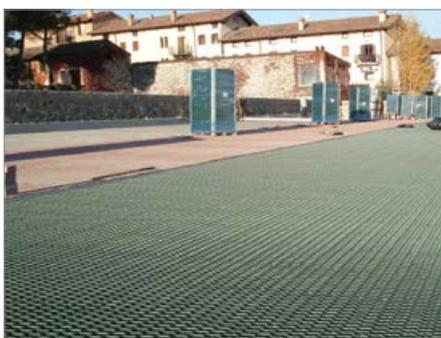
La praticité de l'ancrage, la légèreté de chaque grille, la possibilité de moduler la forme (il suffit d'une scie) permettent une mise en place rapide d'E.C.O. di PRATOPRATICO® pour les grandes superficies comme pour les petites.
