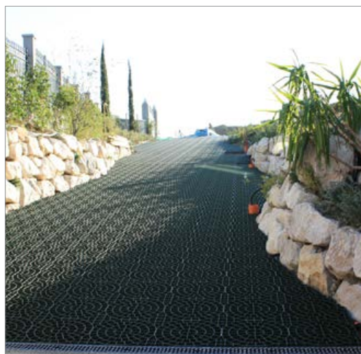
Rampe d'accès - pose
