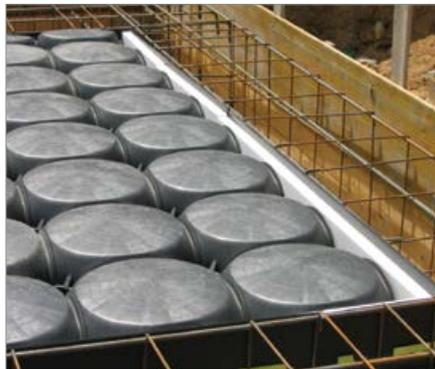
**5** Superponer, siempre bloqueándolos con estribos y collares, otros paneles en función de la altura que se tiene que alcanzar. Completar el montaje de los Atlantis y tapar con los listones de poliestireno el lado que ha quedado abierto de los encofrados a lo largo del perímetro.
