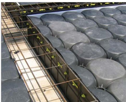
Para crear, en una sola fase, la losa superior (de huecos) y las vigas de cimentación perimetrales e internas de una obra.
