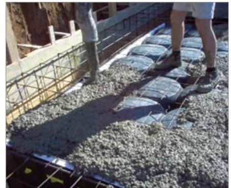
**6** Empezar la fase de colada del hormigón partiendo por los pilarotes para continuar con los cordones y la losa.
