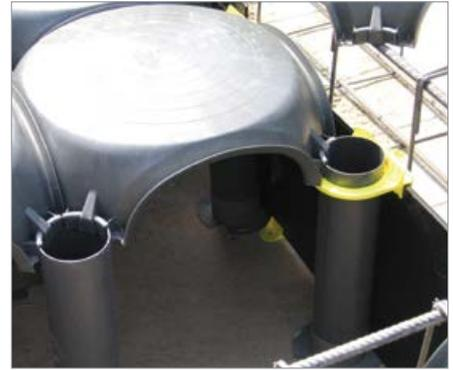
**3** Disponer el panel de partida insertándolo en la guía prevista de los estribos inferiores y bloqueándolo por arriba con los collares insertados en los pilarotes.
