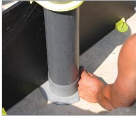
**2** Clavado al suelo, a lo largo de las vigas de cimentación internas y perimetrales, de los estribos inferiores y de las patas de los tubos equidistantes con un paso de aproximadamente 50 cm.
