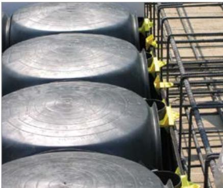
**4** Después de haber montado los primeros encofrados Atlantis, colocar los estribos intermedios en el panel y seguidamente proceder a unir entre ellos los estribos y los collares de los pilarotes contrapuestos utilizando unas horquillas de acero (a preparar en la obra).
