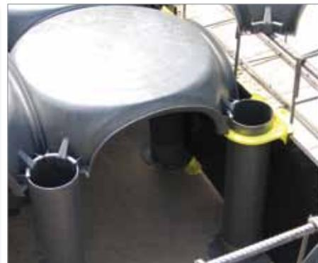
**3** Disporre il pannello di partenza inserendolo nell'apposita guida delle staffe inferiori e bloccandolo superiormente con i collari infilati sui tubi.
