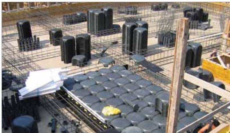
**Cassaforma Muro** coerentemente con lo scopo che persegue, ossia velocità e facilità di esecuzione del lavoro di cantiere, è caratterizzato da poche parti semplici e leggere che consentono un montaggio intuitivo e rapido dai molteplici vantaggi:
