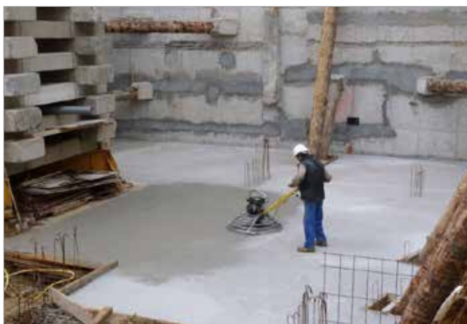
Getto e successiva lisciatura del calcestruzzo
