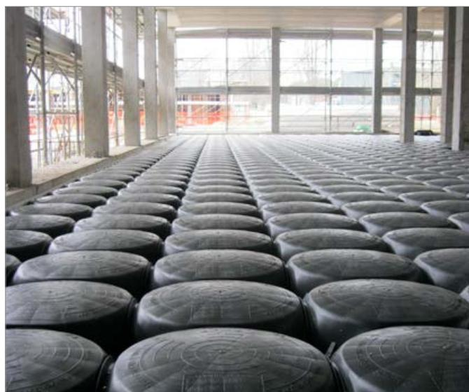
Cámara de aislamiento para edificio para uso sanitario
