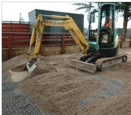
**1 REALIZZAZIONE DI UNO STRATO PERMEABILE** (pietrisco di grana variabile 3-10 mm) di circa 15-20 cm. Eventuale strato di allettamento di sabbia silicea opportunamente livellata di ca. 4 cm. Posa del geotessuto prima dello sviluppo della pavimentazione.
