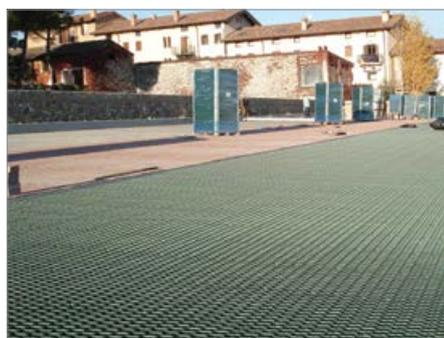
La practicidad del enganche, la ligereza de las rejillas y la posibilidad de obtener distintas formas (basta utilizar una sierra normal) permiten colocar E.C.O. de manera rápida y eficaz en superficies de dimensiones grandes o pequeñas. Después de preparar una explanada portante adecuada para la naturaleza del lugar y para su destino de uso, es necesario seguir este procedimiento:
