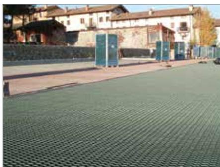
A simplicidade do engate, a leveza das várias grelhas, a facilidade de modelar as várias formas (basta uma simples serra) permitem uma rápida e eficaz posta na obra de E.C.O. seja para as grandes superfícies que para as pequenas.
