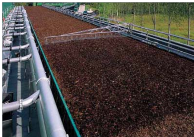
Estação de biofiltração
