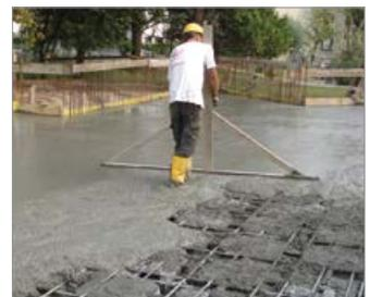
Detalles fotográficos de la secuencia completa de colocación del entablado, colocación de U-Boot<sup>®</sup> Beton, armadura de la estructura a realizar en la obra, colada y alisado final.
