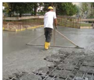
Detalhes fotográficos da sequência completa de escoramento, colocação de U-Boot ® Beton, armadura da estrutura a realizar na obra, betonagem e alisamento final.
