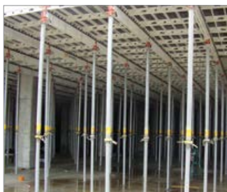
Detalhes fotográficos da sequência completa de escoramento, colocação de U-Boot ® Beton, armadura da estrutura a realizar na obra, betonagem e alisamento final.
