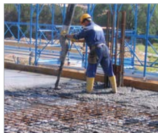
Detalhes fotográficos da sequência completa de escoramento, colocação de U-Boot ® Beton, armadura da estrutura a realizar na obra, betonagem e alisamento final.
