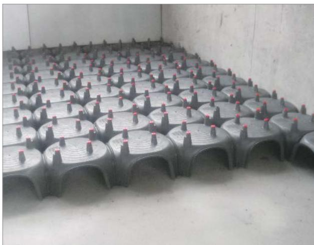
Eolo constituye el remedio eficaz, rápido y asequible que permite realizar un pavimento perforado de cemento armado con alta capacidad portante, transitable también por parte de medios pesados.
