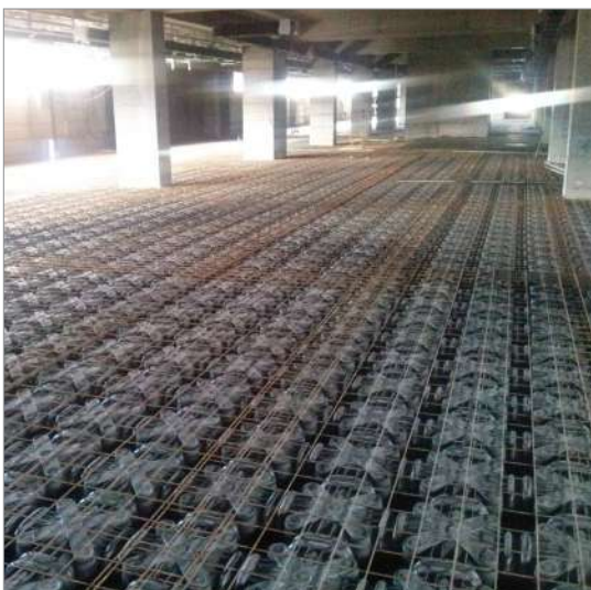
Belüftungshohlraum für Industriegebäude
