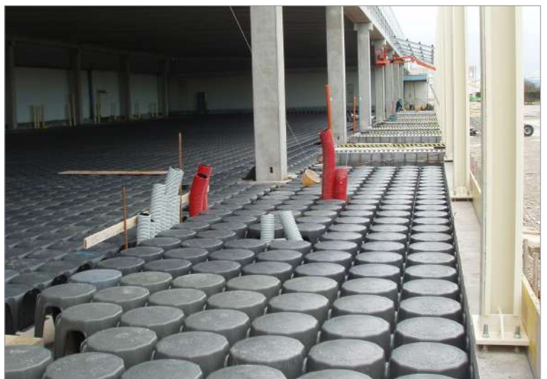
Belüftungshohlraum für Industriegebäude
