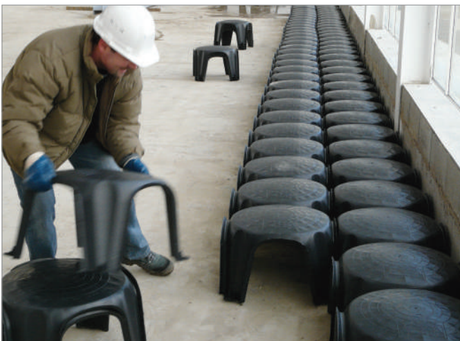
Abb. 3 - Detail der Steckphase des Nut-Feder-Systems - Die vollkommene Versiegelung des Fußes ist deutlich zu erkennen.
