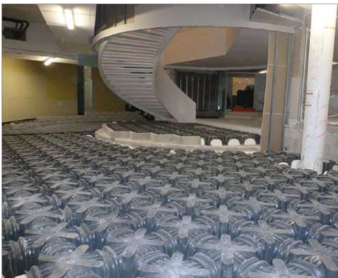
Restaurierung eines historischen Gebäudes
