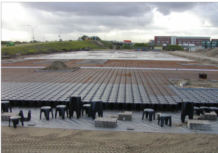
Belüftungshohlraum für Industriegebäude
