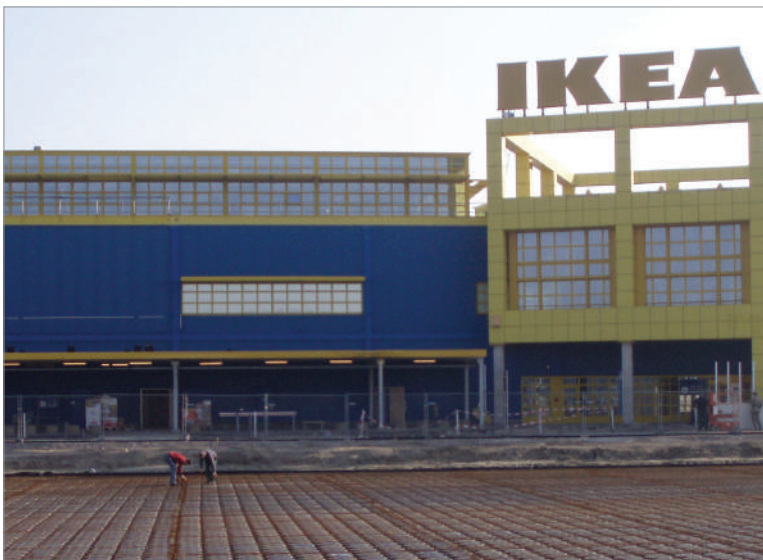
Verteilungsbecken unter einem Handelsparkplatz
