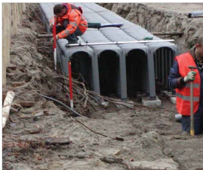
Воздушные прослойки с функцией сохранения корневого сегмента
