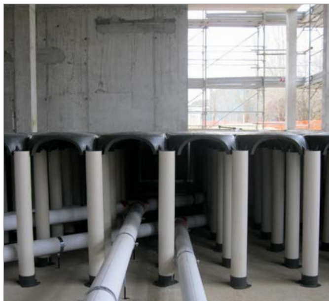
Проводка инженерных сетей под полом в любых направлениях
