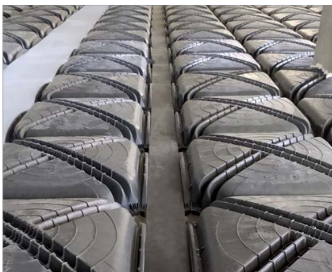
Адаптация к разной геометрии благодаря компенсационным аксессуарам
