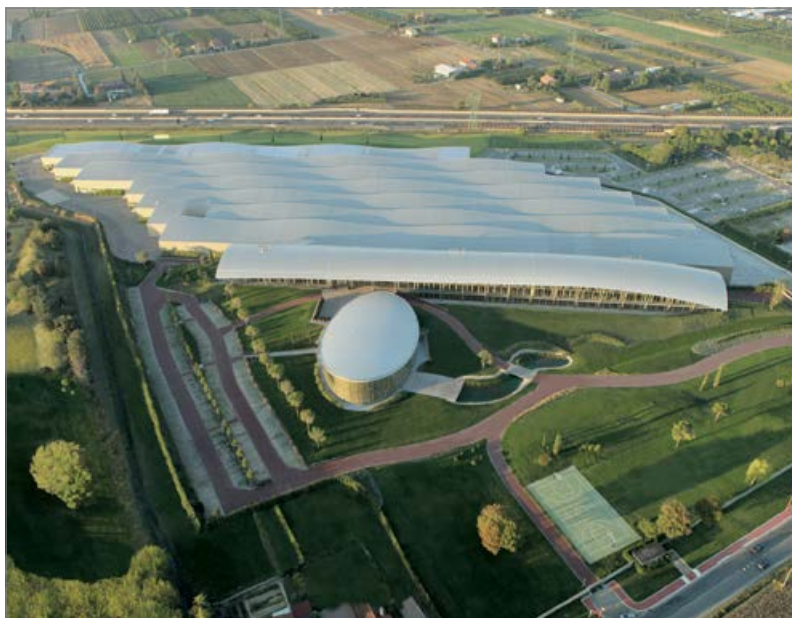
Sede Technogym - парковки и садовые дорожки
