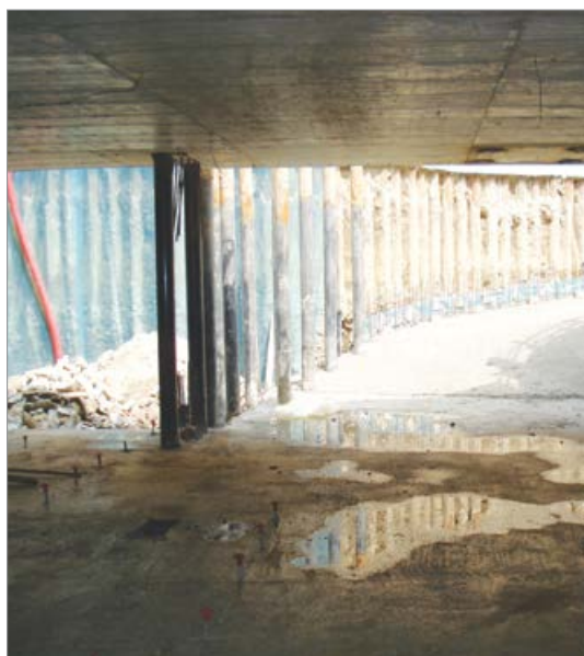
Примеры применения: подземная парковка, выполненная посредством технологии 'top-down'.
