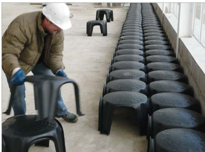
Рис. 3 - Деталь фазы замкового сцепления - Необходимо отметить превосходное сцепление ножки.
