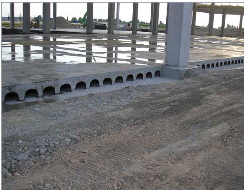
Вентилюемая воздушная прослойка для холодильной камеры
