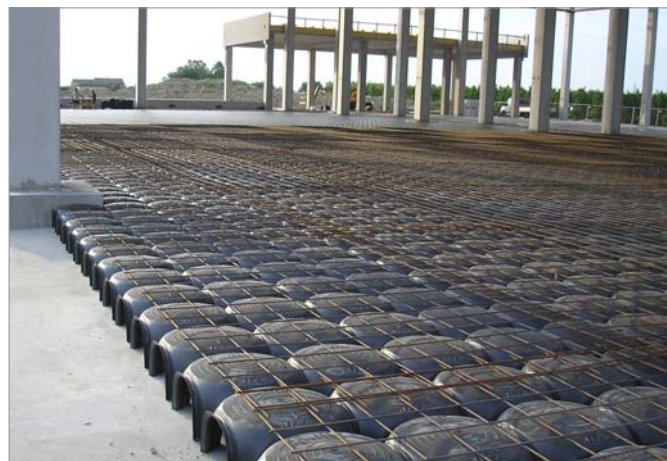
Вентилируемая воздушная прослойка для холодильной камеры
