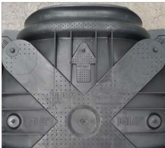
Рис. 1 - Установка всухую первого элемента опалубки, стрелка направлена к обвязке фундамента.
