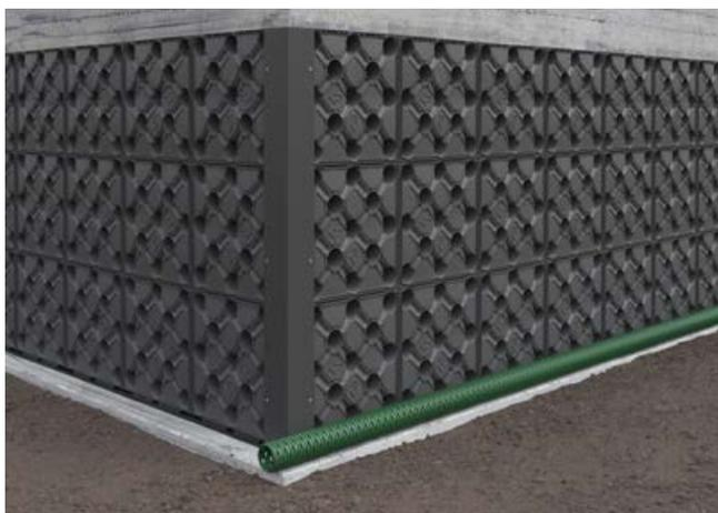
Posare il tubo di drenaggio lungo il perimetro dell'edificio e vicino alla parete.
