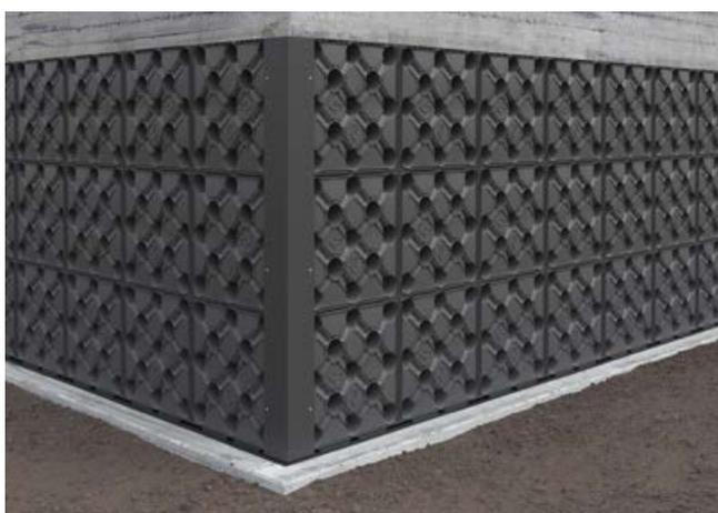
Posizionare la chiusura angolare in modo da proteggere l'intercapedine dalle infiltrazioni, bloccandola al pannello Iglu<sup>®</sup> Barrier con viti o tasselli chimici di lunghezza non superiore a 3 cm, in modo da non forare l'impermeabilizzazione.
